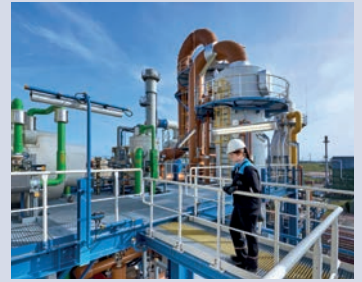
2020 – Durch Inbetriebnahme der neuen MDI-Anlage mit einer Kapazität von 400.000 Tonnen im Jahr setzt Covestro neue Maßstäbe hinsichtlich Energieeffizienz, Umweltverträglichkeit und Produktivität. © Covestro
