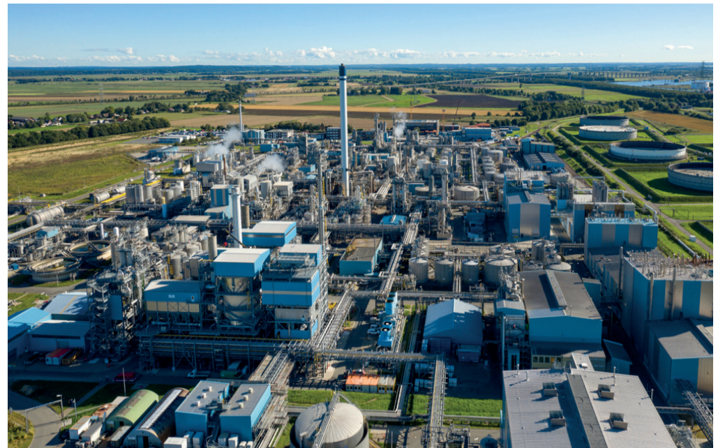
Im Werk Brunsbüttel verfolgt Sasol Projekte für die eigene Energiesicherung. © Sasol Germany GmbH
