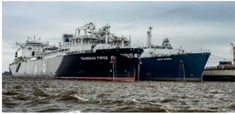
Der Norden liefert Energie: Schwimmendes LNG-Terminal. © Brunsbüttel Ports GmbH
