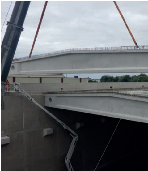
Montage der jeweils 64 Tonnen schweren Dachbinder. © KBR
