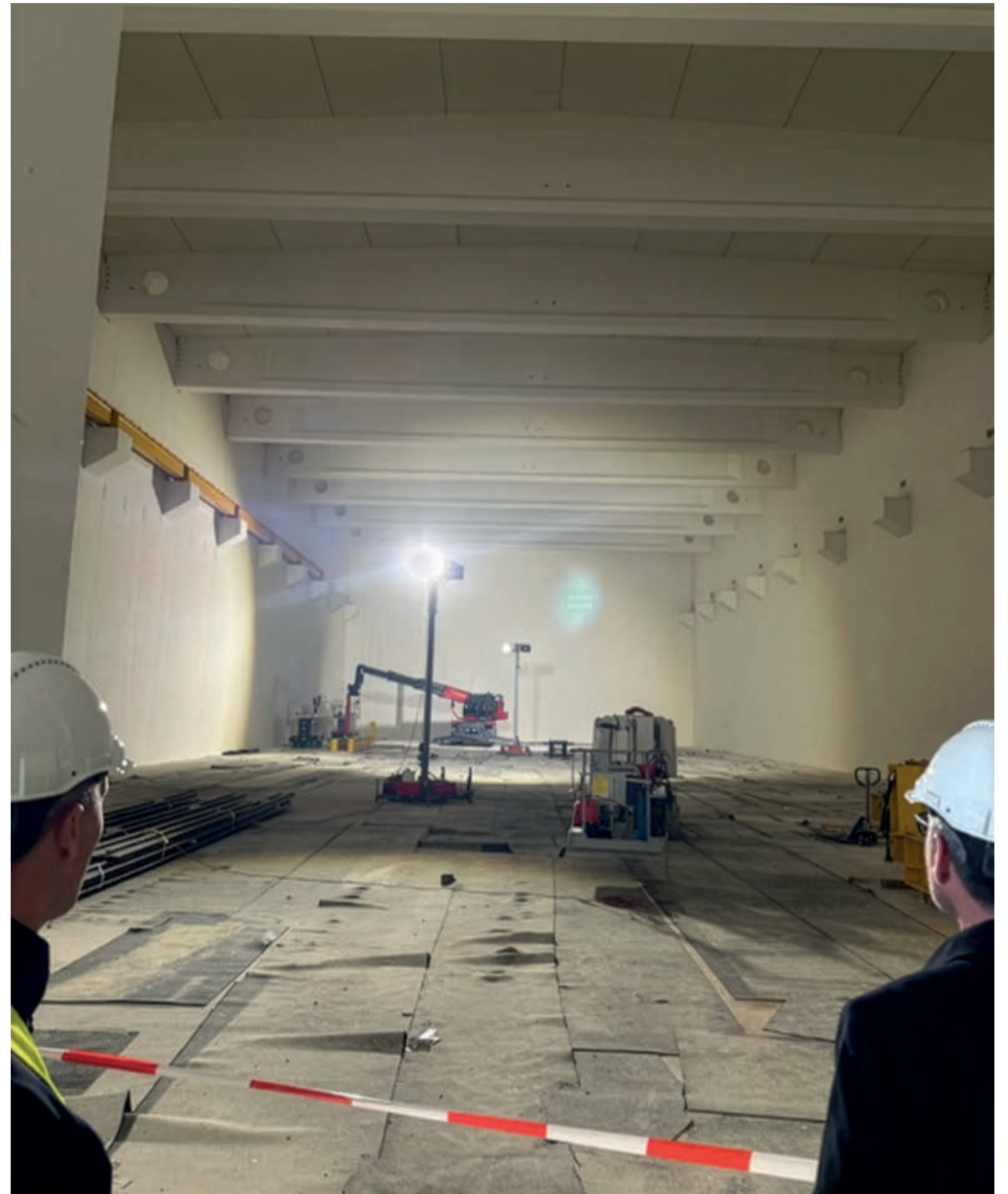
Beim Richtfest: Blick in die Transport- und Bereitstellungshalle. © KBR
